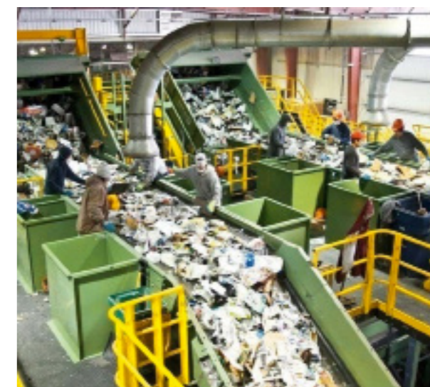
Первый в Ростовской области межмуниципальный экологический отходоперерабатывающий комплекс (МЭОК). г. Волгодонск
